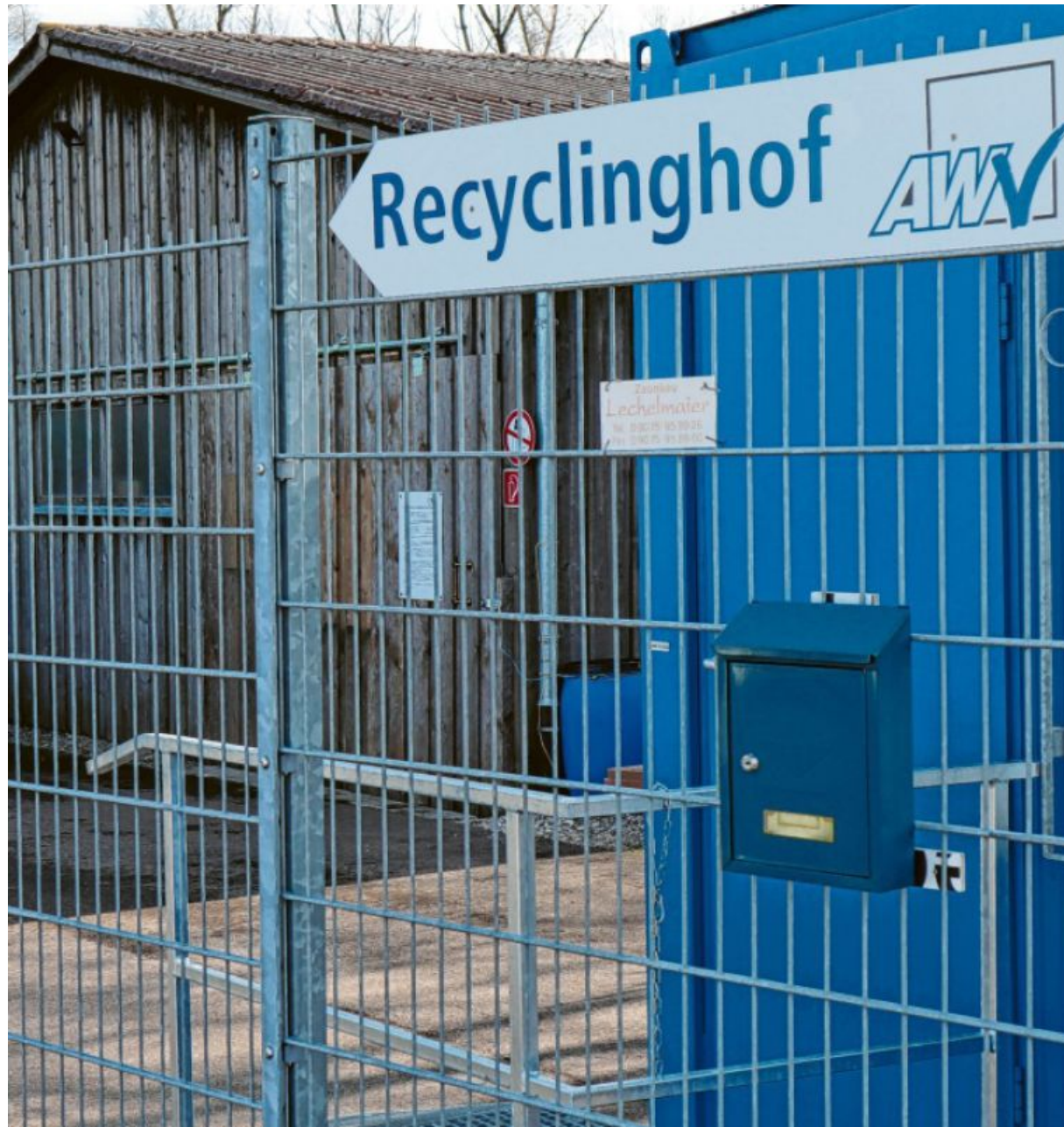
Der Recyclinghof von Höchstädt wird neu gebaut.
